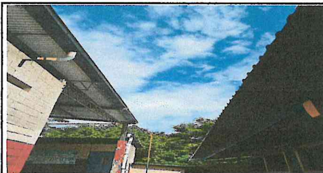
Foto 5: Instalación de lamina troquelada en el pasillo
