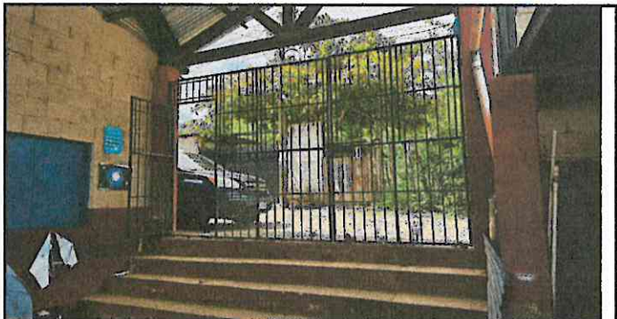
Foto 4: Sustitución de Portón de metal
